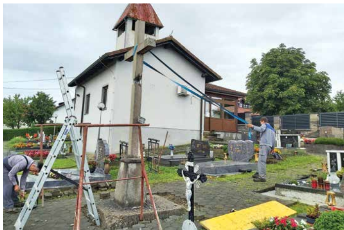
Delavci režijskega obrata so pomagali pri odstranitvi.
